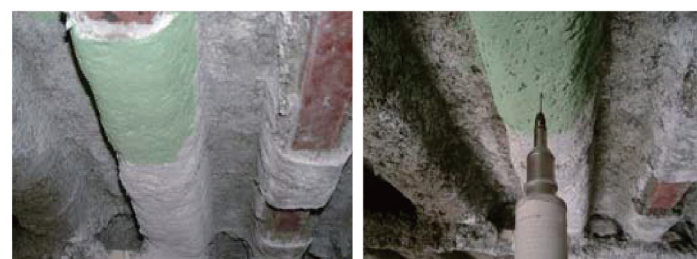
ASK施工後6年 全厚封じ込め維持
